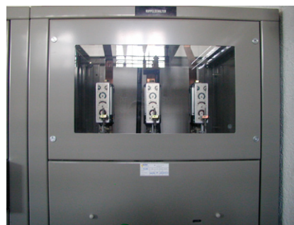
Bild 6: Panel-Gardy-Zelle vor dem Umbau
