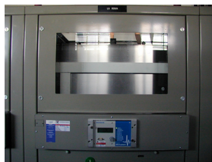
Bild 7: Panel-Gardy-Zelle nach dem Umbau
